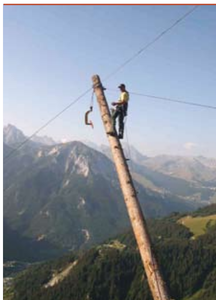
Installation d'une ligne de câble à Champagny en Vanoise
