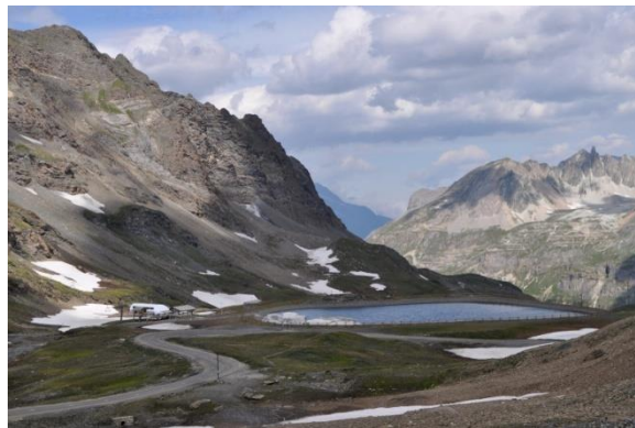
Photo 15 : Vue de la retenue artificielle réalisée sous le col de l'Iseran, nouvel ouvrage dans ce paysage d'altitude déjà bien aménagé
