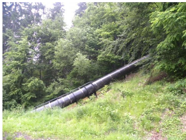
Photo 32 : Conduite forcée pour l'hydroélectricité (Le Villard du Planay)
