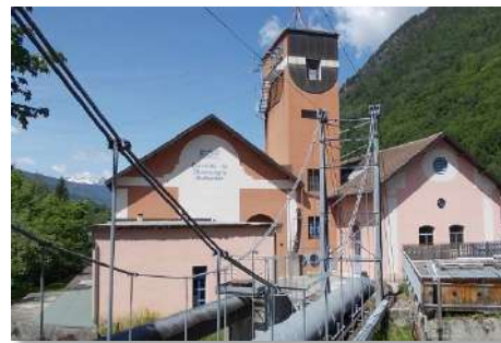
Centrale hydroélectrique de Champagny Ballandaz
