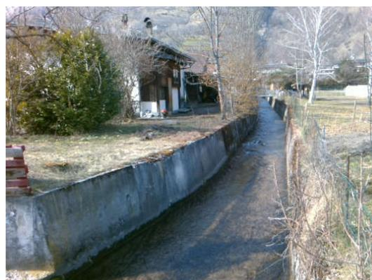
*Chenal d'écoulement dans une goulotte bétonnée
