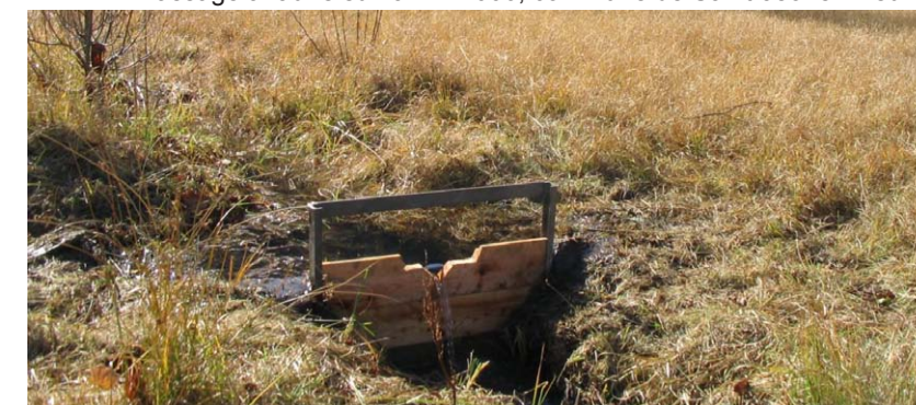
Seuil sur le site des Creusates, commune de Saint-François-de-Sales
