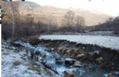
Digue sur le ruisseau de Bonnegarde (Macôt)
