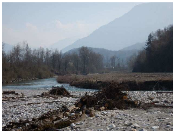
Travaux d'essartement de la végétation par EDF –
