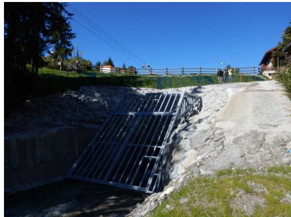
Reprise de l'entonnement du remblai des Ravines
