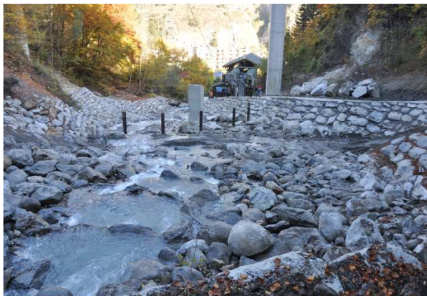
Construction d'un piège à flottant et confortement du cône de déjection sur la partie amont
