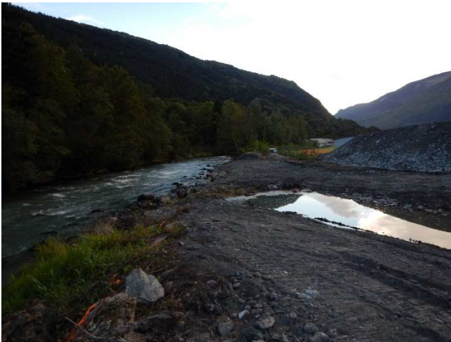
Aime : En phase travaux
