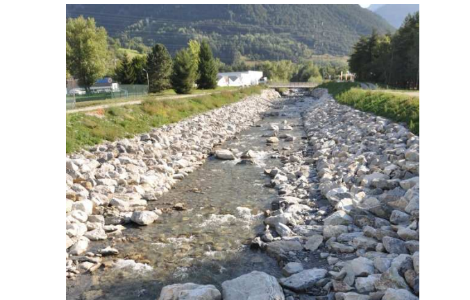
Bourg Saint Maurice : création d'une plage de dépôt, protection des berges, augmentation de la section hydraulique sous le pont RD
