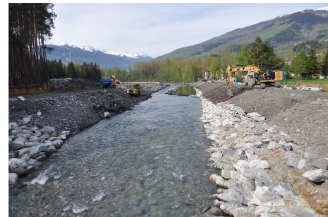
Bourg Saint Maurice : création d'une plage de dépôt, protection des berges, augmentation de la section hydraulique sous le pont RD
