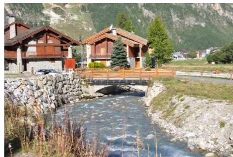
Travaux de protection sur le secteur du Laisinant
