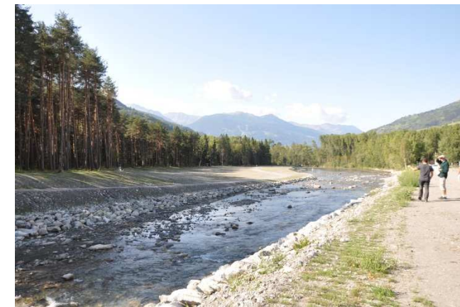
Bourg Saint Maurice : création d'une plage de dépôt, protection des berges, augmentation de la section hydraulique sous le pont RD
