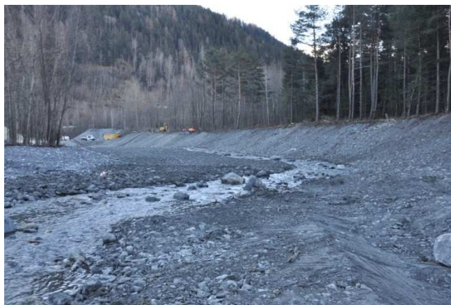
Séiez : création de deux plages de dépôt, élargissement de la largeur du torrent, reprise de l'entonnement du pont
