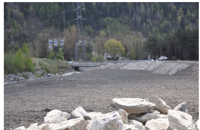
Bourg Saint Maurice : création d'une plage de dépôt, protection des berges, augmentation de la section hydraulique sous le pont RD
