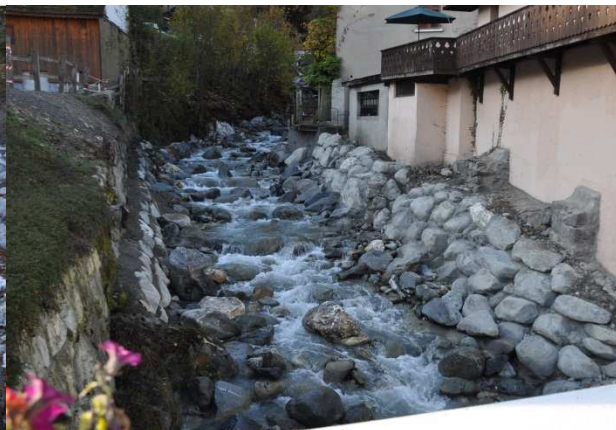
Confortement de berges dans la traversée du centre de Brides-les-Bains
