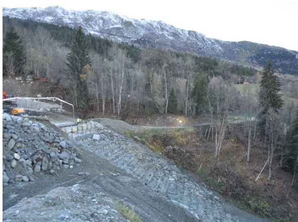
Réalisation d'un parcours à moindre dommage et d'un coursier
