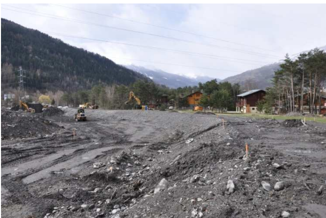
Séiez : création de deux plages de dépôt, élargissement de la largeur du torrent, reprise de l'entonnement du pont
