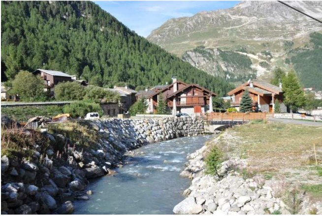
Val d'Isère : secteur du Laisinant – protection des berges
