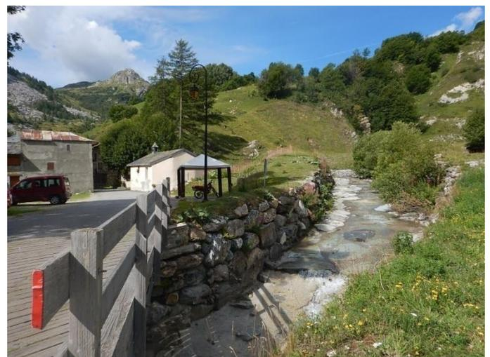
*Radier en enrochement et digue en amont du pont de la route communale*
