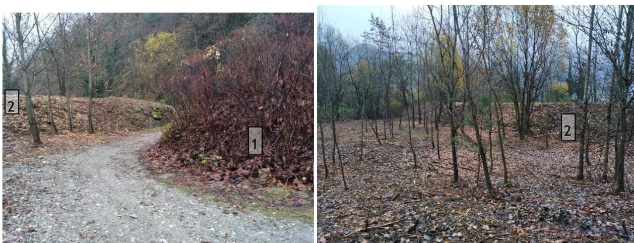
*Epis – digue à l'apex du cône de déjection, passage en chicane entre les deux ouvrages*
