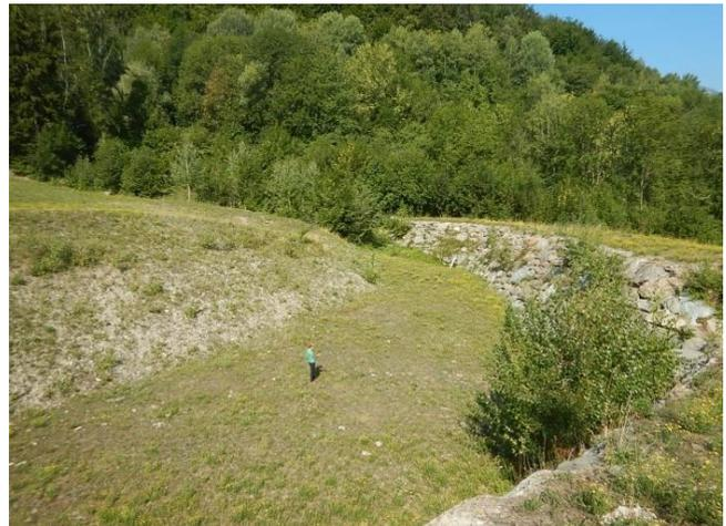
*Plage de dépôt aval, en deux « terrasses », barrage de fermeture aval en remblais et parement en enrochement*
