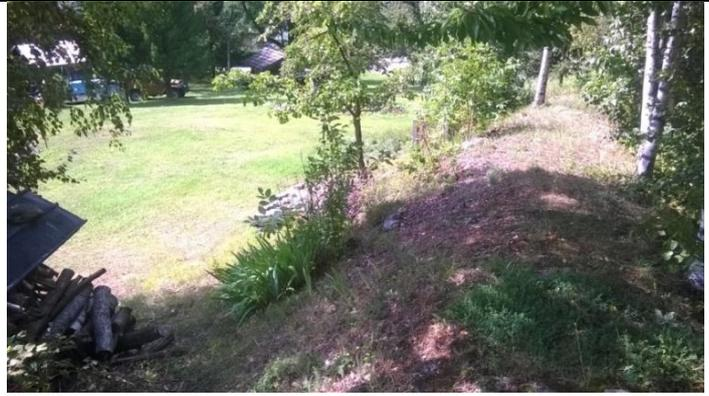
*Digues en remblais sur le cône de déjection*
