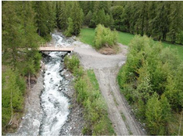
*Passerelle intermédiaire sur le nant Fessons et digues en remblais en rive gauche, disposées en « écailles » (photo ETRM 2020)*
