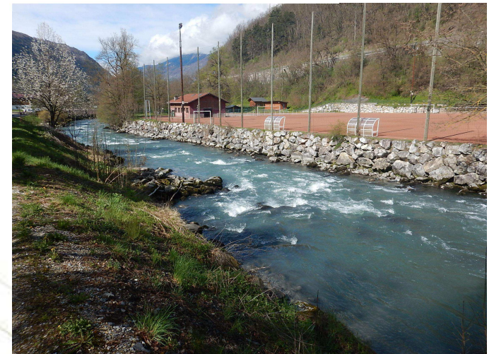
Protections de berge
