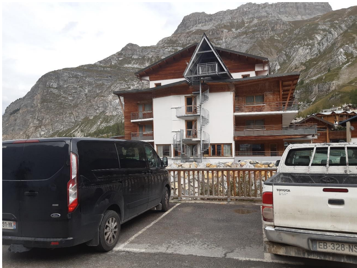
Le centre de vacances sur la partie rive droite de l'Isère :
